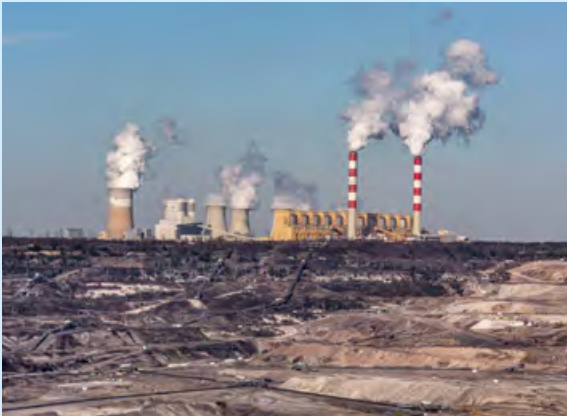
Das Braunkohle-Kraftwerk Belchatów mit dem zugehörigen Tagebau im Vordergrund
